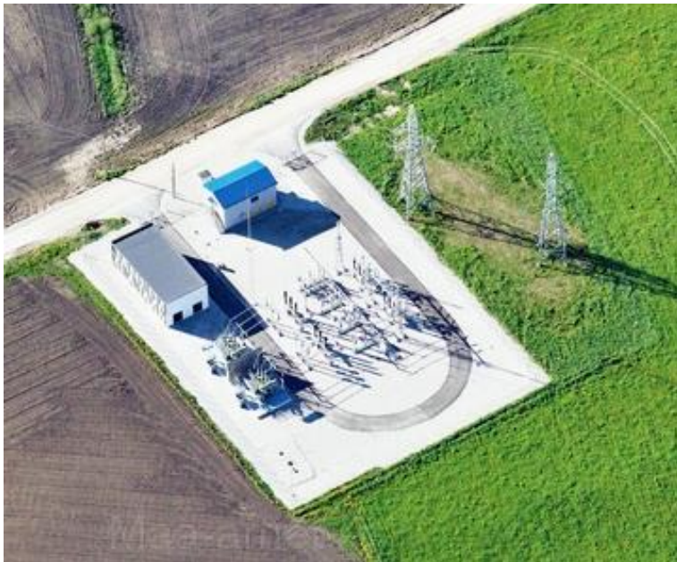
Joonis 5. 110 kV alajaama illustatsioon – Jänedal alajaam. Allikas: Maa-amet Kaldaerofoto.
